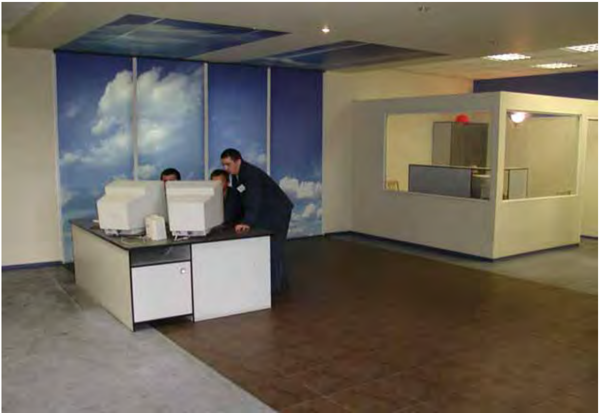
Рис.2 Щит управления котлом БКЗ-210 Бийской ТЭС-1.
