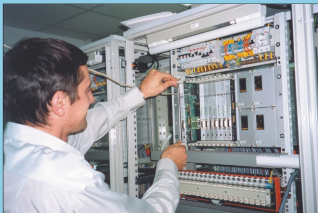
Сборка шкафов контроллеров на площадях ЗАО "МСТ"
